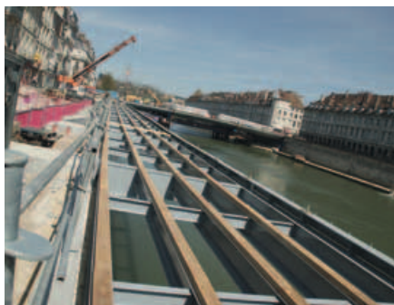
18 AVRIL 2013 : TRAVAUX DE POSE DE L'ENCORBELLEMENT DU QUAI VEIL-PICARD
