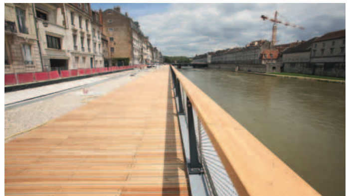
↑ L'ENCORBELLEMENT DU QUAI VEIL PICARD EST TERMINÉ! PROFITEZ BIENTÔT DE CETTE NOUVELLE PROMENADE AU DESSUS DU DOUBS.
