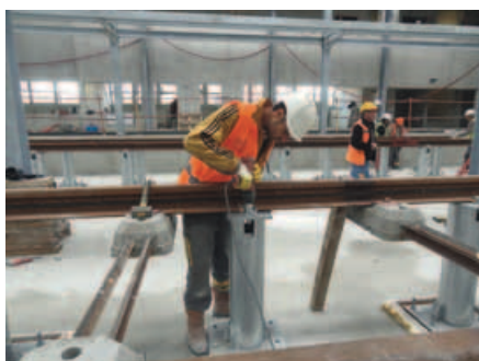
LA CONSTRUCTION DES ATELIERS DU CENTRE DE MAINTENANCE SE POURSUIT.
